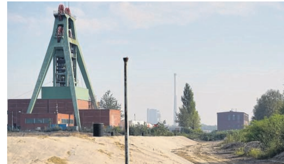
Der Förderturm über Aden II hat mit der Verfüllung ausgedient – und dort auch als Wahrzeichen keine Zukunft. Hier Grubenwasserhebeanlage entstehen, möglichst mit einer Wärmegewinnung. Ob das Schachtgerüst als Erinnerungstück versetzt werden kann, prüfen Fachleute noch. Ein Ergebnis wird im März erwartet.
