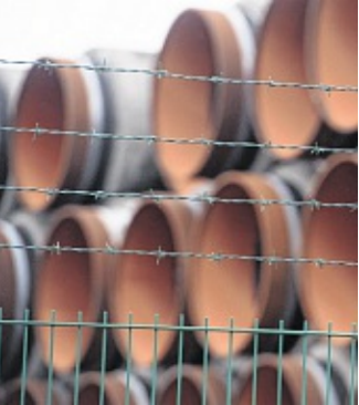
Rohre für die Ostsee-Gaspipeline FOTO: DPA/SAUER
