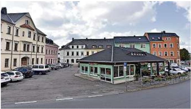
Der Obertorplatz in Dippoldiswalde soll umgestaltet werden.
