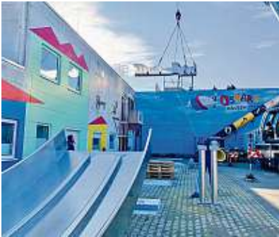
Diese Woche wurde eine neue Wellenrutsche montiert. Benutzt werden darf sie aber noch nicht. Foto: privat
