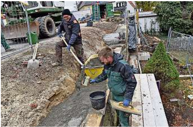
Mitarbeiter der Freiburger Firma LSTW sichern derzeit die Stützmauern an der Alten Altenberger Straße unweit des Busbahnhofes.
