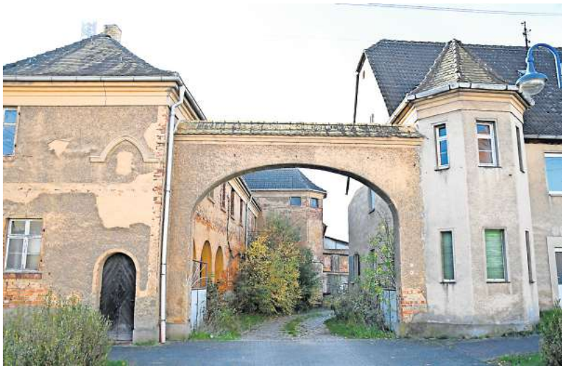
Das ehemalige Rittergut in Pressel verfällt immer weiter. Jetzt soll es wieder Gemeindeeigentum werden.
