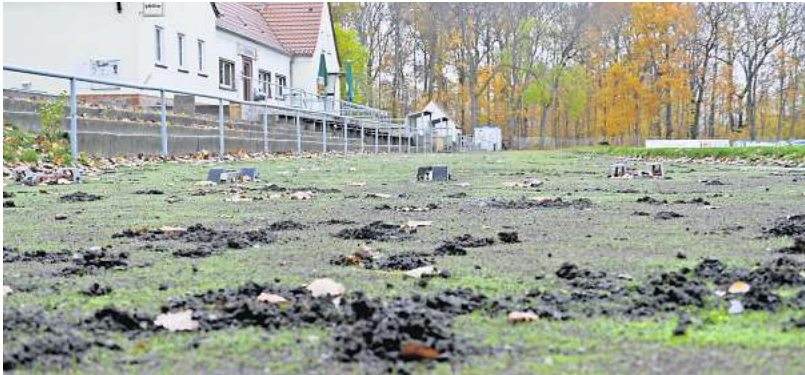
Nicht allein die alte Aschebahn hat im Krostitzer Kurt-Fuchs-Stadion eine Sanierung nötig.
