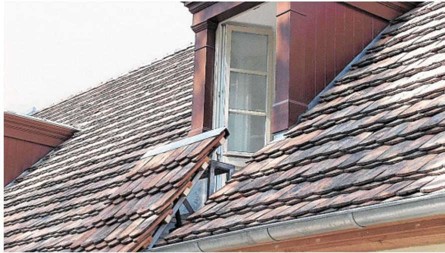
**Fluchtweggaube:** Bei diesem System lassen sich zwei Stufen über die Traufe hinweg nach außen klappen, sodass sie eine geeignete Rettungsfläche für die Feuerwehr bieten. FOTO: SOLTKAHN
