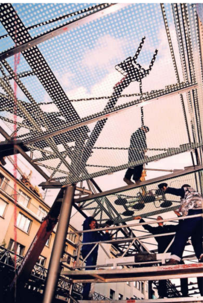
Der Einbau der Glasdächer entlang der Königstraße war absolute Maßarbeit. Die Straße erhielt auch ein neues Pflaster.
