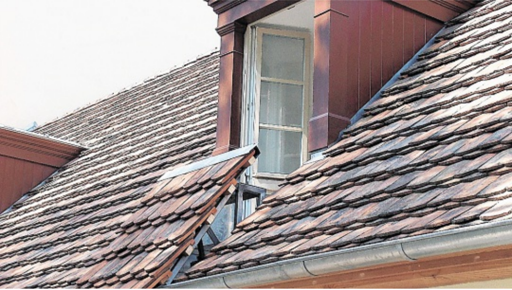
Fluchtweggaube: Bei diesem System lassen sich zwei Stufen über die Traufe hinweg nach außen klappen, sodass sie eine geeignete Rettungsfläche für die Feuerwehr bieten.
