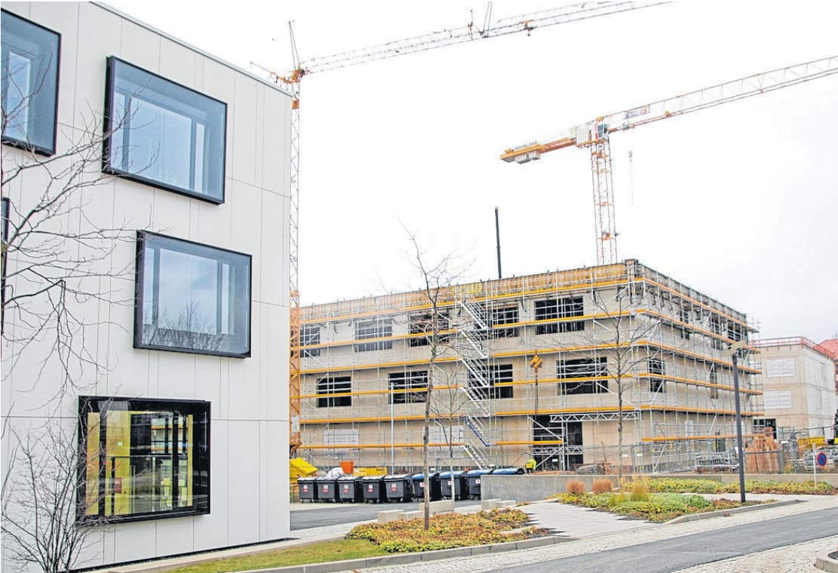
Der Innenausbau kann beginnen: Neben dem Nordflügel (links im Bild) des Clemens-Winkler-Baus an der Leipziger Straße sind jetzt der Mittel und der Südflügel (rechts hinten) im Rohbau fertiggestellt worden. FOTOS: WIELAND JOSCH (2)
