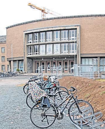
Das markante Altgebäude soll ebenfalls hergerichtet werden.
