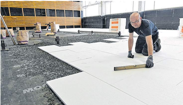
Die Oberschönaer Turnhalle erhält einen neuen Sportboden.
