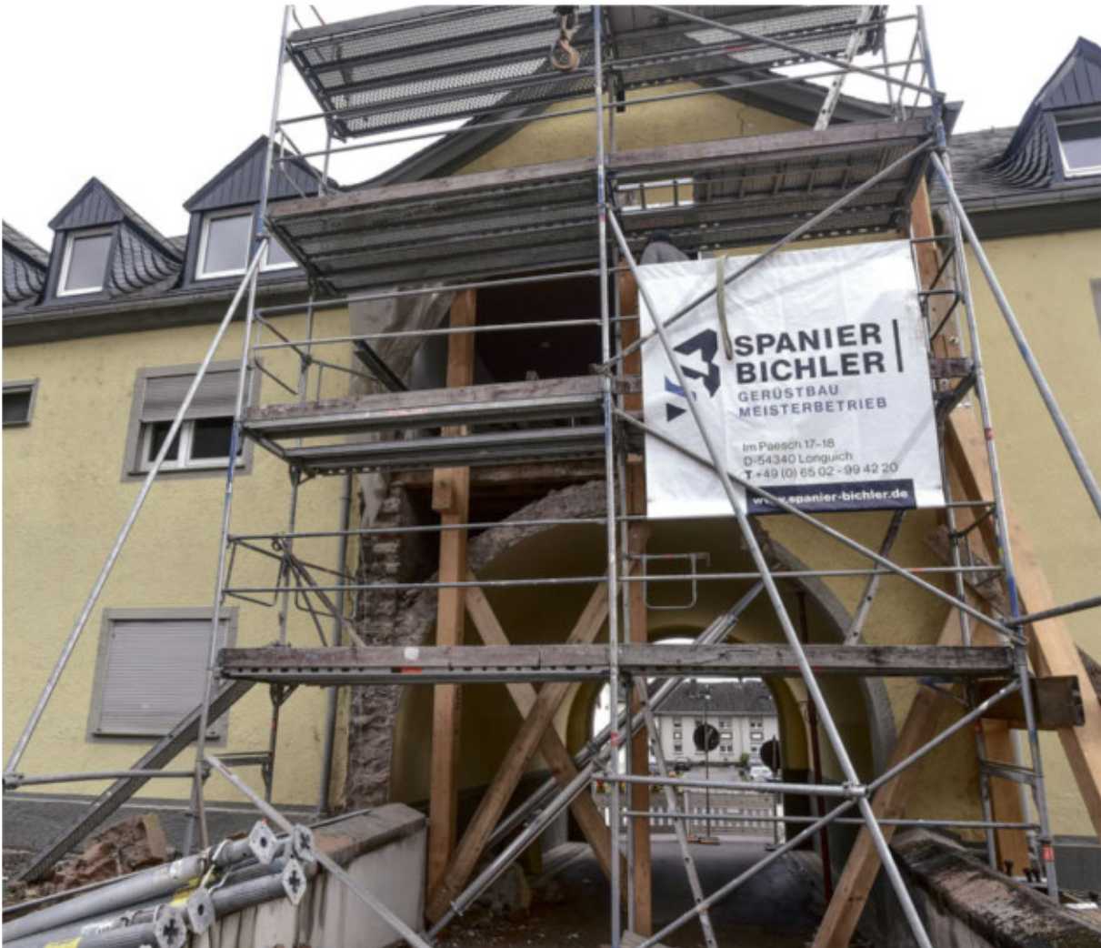
Giebelwand und Torbogen des durch den LKW-Unfall zerstörten Hauses am Mittelplatz in Trier-Ehrang sind mit dicken Holzpfählen abgestützt. Der Bauschutt liegt immer noch im Hof.
