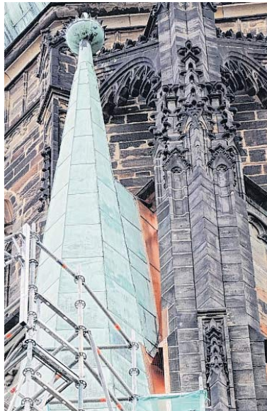
Neue Kupferbleche sollen das Eindringen von Feuchtigkeit verhindern.
