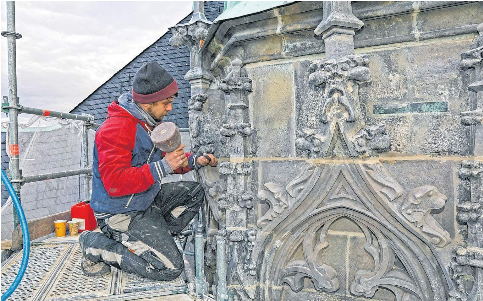
Philipp Lier bearbeitet als Bildhauer die neu eingesetzten Sandsteine unterhalb des Turmhelms so, dass sie sich denkmalgerecht in die Substanz einfügen.
