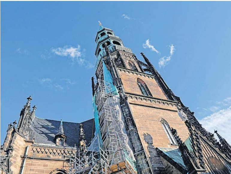
Ende November werden die Gerüste am Treppen- und Aufzugsturm neben dem Haupteingang des Turms fallen.
