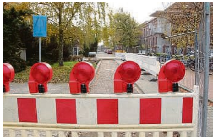
Der Weg zwischen Klinik-Haupteingang und Ackerstraße wird auf 3,5 Meter Breite aufgeweitet. FOTO: ALTMARKKLINIKUM
