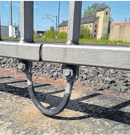
Hat sich im elektrischen Bahnbetrieb bestens bewährt: die Bahnerdung. FOTO: KAIP
