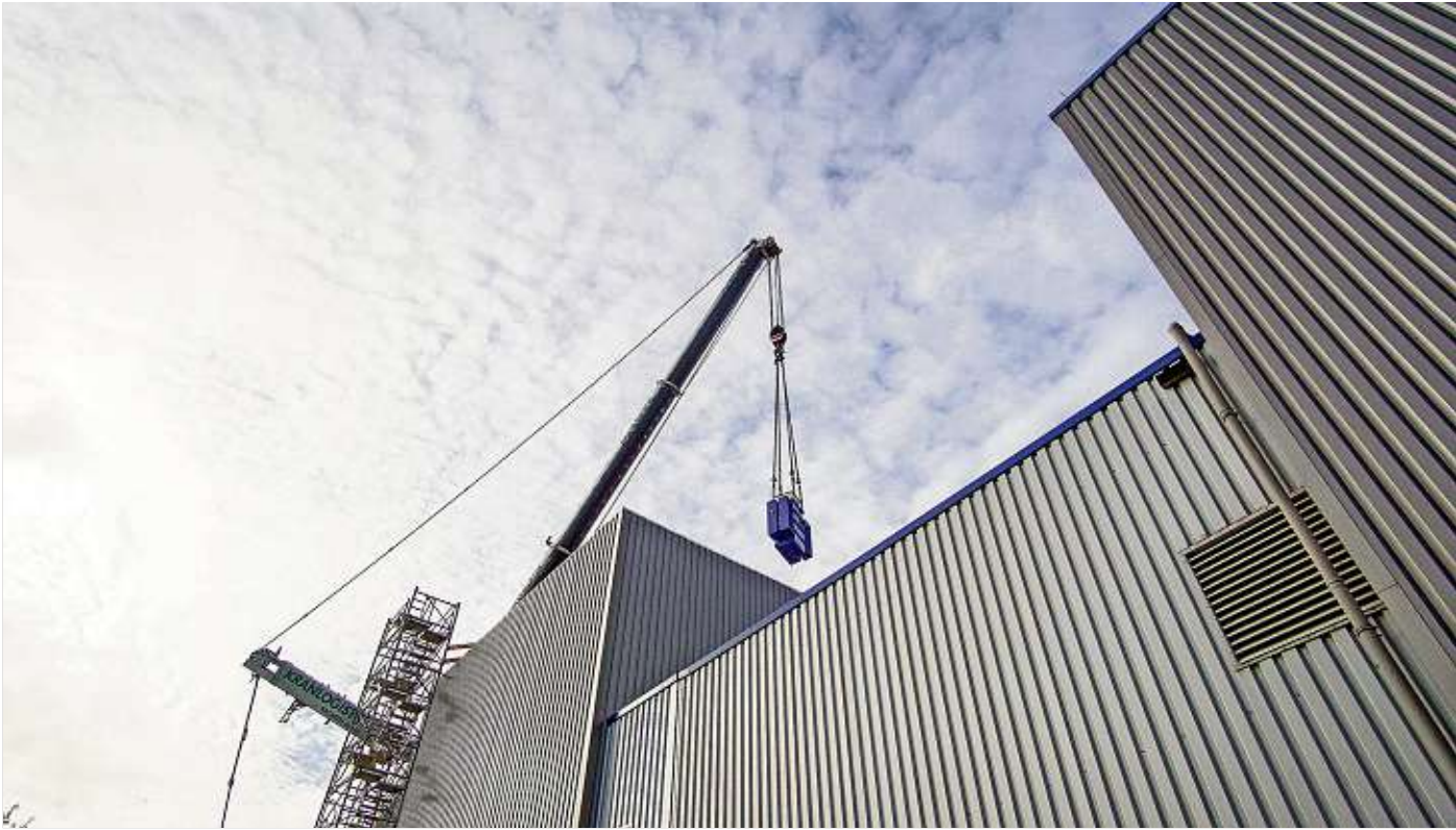
Ein riesiger Kran hievte die Teile für den neuen Elektronenbeschleuniger über die jüngste Werkhalle von Ionisos.
