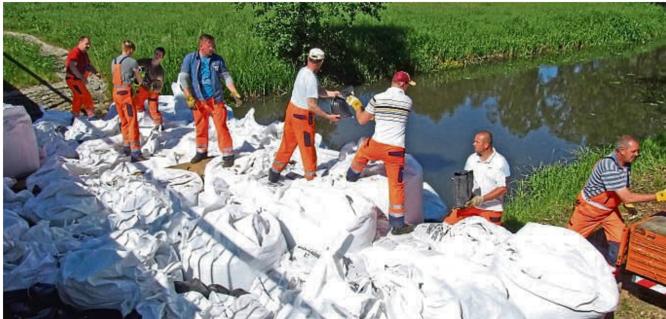
Die Wasserwehr koordinierte auch diesen Einsatz im Juni 2013 im und am Zehrengaben.
