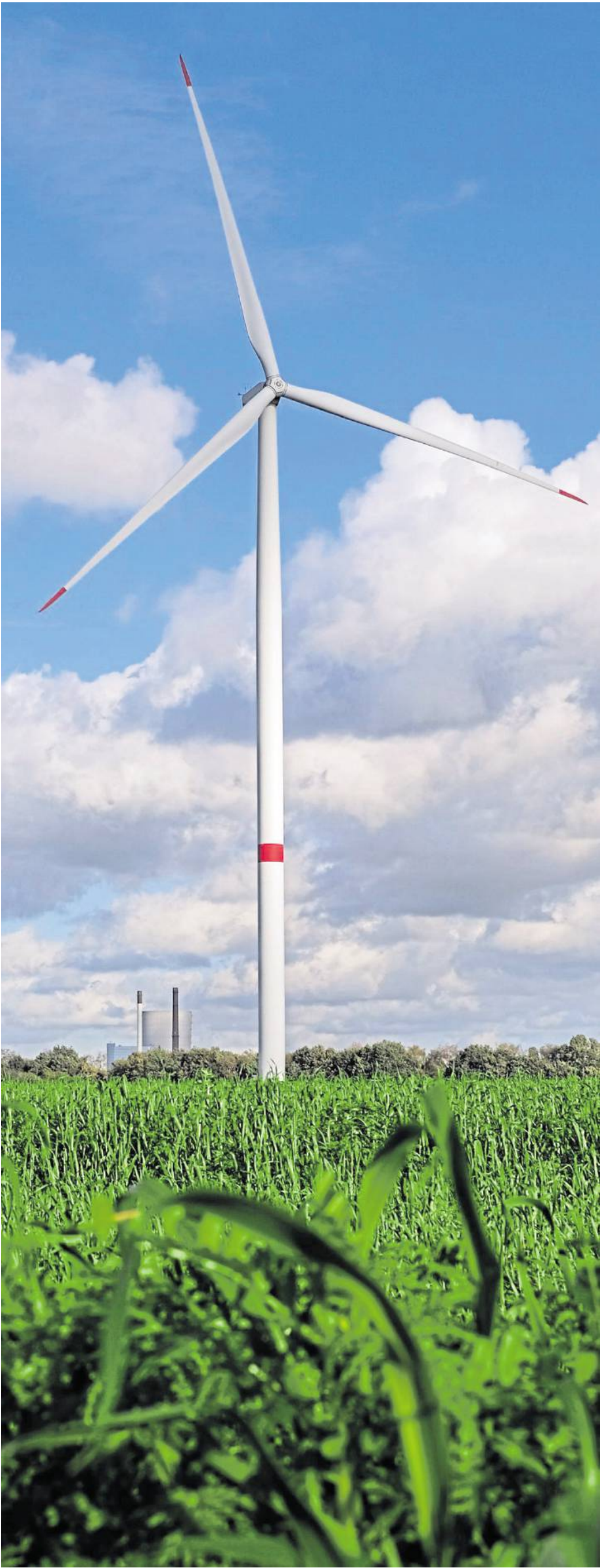
180 Meter hoch ist das Windrad zwischen Becklem und Datteln-Horneburg. Noch einmal knapp 60 Meter höher soll das Paar in Datteln werden. —FOTO: ANDREAS KALTHOFF
