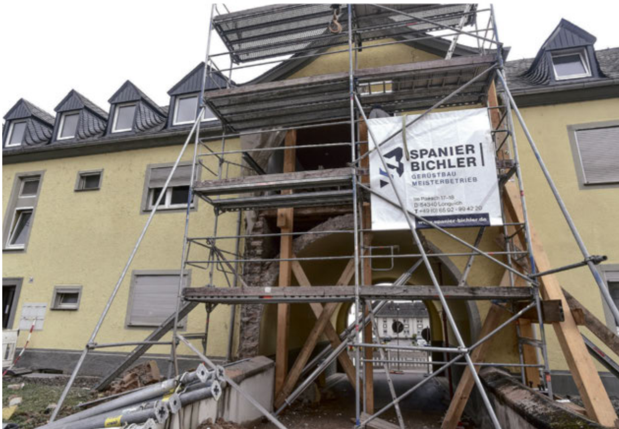
Giebelwand und Torbogen des durch den LKW-Unfall zerstörten Hauses am Mittelplatz in Trier-Ehrang sind mit dicken Holzpfählern abgestützt. Der Bauschutt liegt immer noch im Hof.
