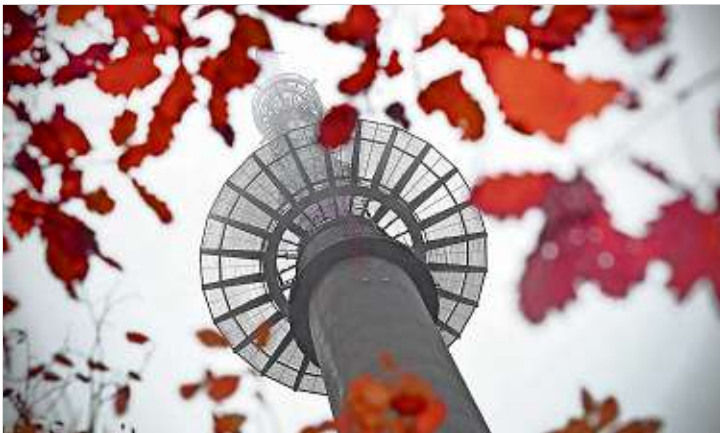
Der 162 Meter hohe Sendeturm auf dem Löbauer Schafberg strahlt neben TV-Signalen auch digitalen Hörfunk aus. Foto: SZ-Archiv/M. Weber
