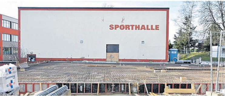
Beim Bau der zweiten Turnhalle am Evangelischen Schulzentrum Schöneck sind die Arbeiten mittlerweile bis zur Errichtung der Bodenplatte vorgerückt. Dennoch ist der ursprünglich ambitioniert formulier- te Zeitplan nicht mehr zu halten – bis Ende November sollte schon der Rohbau stehen. Rund 1,3 Millionen Euro sind für das Vorhaben in Regie des OVV veranschlagt. |tb FOTO: ECKHARD SOMMER
