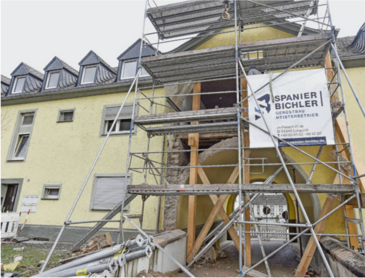
Giebelwand und Torbogen des durch den LKW-Unfall zerstörten Hauses am Mittelplatz in Trier-Ehrang sind mit dicken Holzpfählen abgestützt. Der Bauschutt liegt immer noch im Hof.
