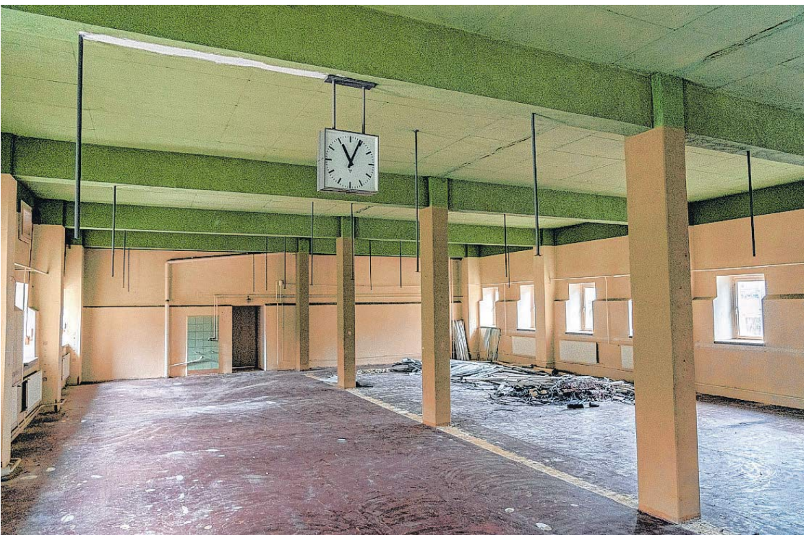
Blick in eine ehemalige Fabriketage: Nach der Sanierung solle das Haus seine Geschichte als Industriebetrieb nicht verleugnen. Alte Uhren und Stromverteilkästen werden in die Gestaltung einbezogen. FOTO: DAVID RÖTZSCHKE
