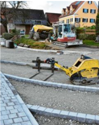
Die Bauarbeiten in Ronheim kommen planmäßig voran. Foto: Widemann
