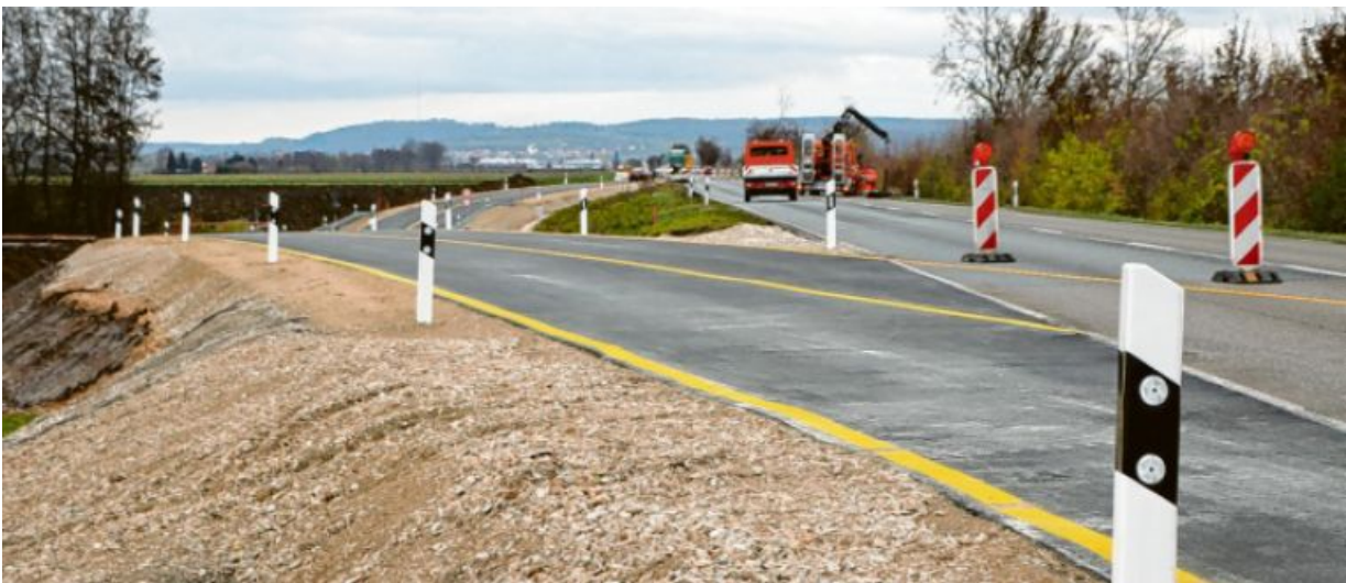
Die Behelfsumfahrung der B 25 ist seit Freitag freigegeben.
