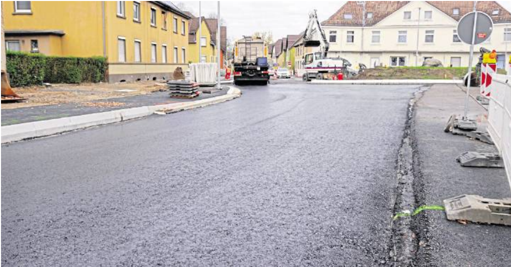
Die neue Tragschicht an der Römerstraße glänzt im Tageslicht.
