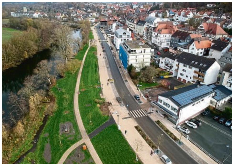
Vorher und nachher: Das obere Foto zeigt die Uferstraße vor zwei Jahren im November 2018 vor dem Umbau. Das untere Foto entstand gestern Mittag vor der Verkehrsfreigabe nach dem Ende der Bauarbeiten.
