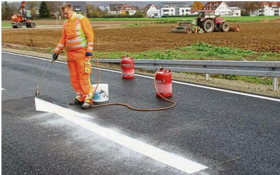
Letzte Markierung, bevor der Verkehr rollen kann: Fahrbahnmarkierer Pascal Bienert trägt im Bild einen Pfeil an der Kreuzung Umgehung/Ederweg auf. FOTO: MANFRED SCHAAKE
