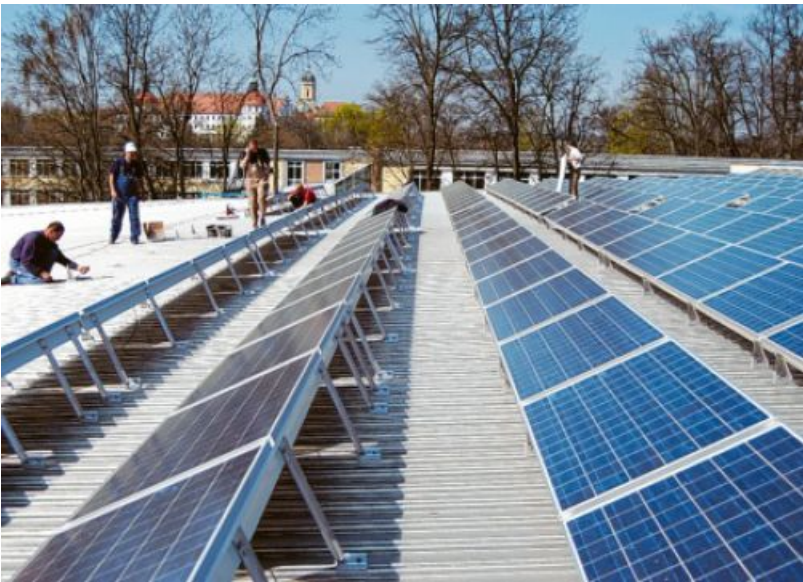
Seit 17 Jahren erzeugt die Solaranlage auf dem Dach der Parkschule, hier bei der Installation 2003, zuverlässig Strom.
