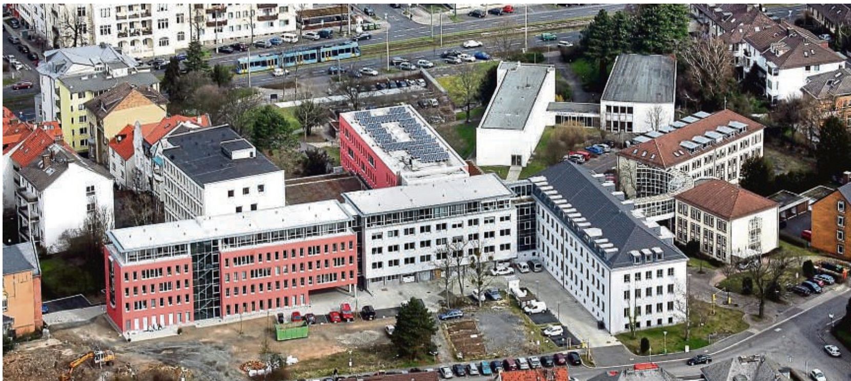
Am 14. März wählen die Bürger des Landkreises Kassel den neuen Chef im Kreishaus. Die Landkreisverwaltung steht an der Wilhelmshöher Allee in Kassel.
