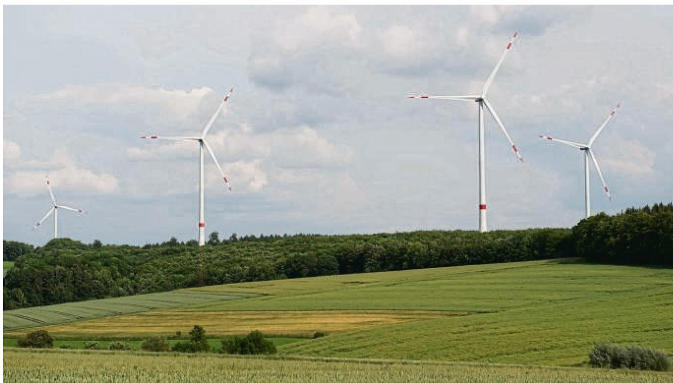
18 Windräder sollen es werden: Die Energiegenossenschaft Reinhardswald will Anlagen (wie diese bei Trendelburg) im Reinhardswald bauen. Infos dazu erhielten diese Woche die Mandatsträger der beteiligten Orte. ARCHIVFOTO: MARKUS LÖSCHNER
