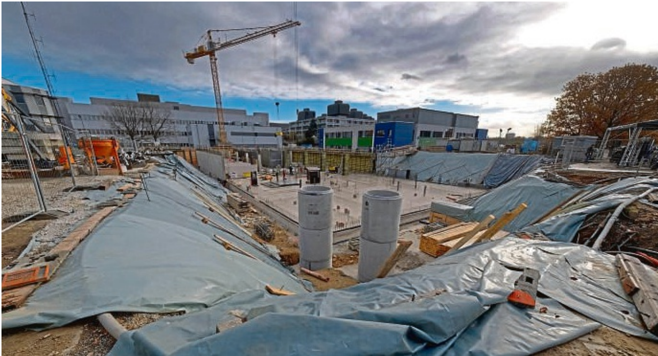
Blick auf die Baustelle für das künftige Forschungszentrum: Es entsteht auf dem Gelände der Universitätsmedizin Göttingen.
