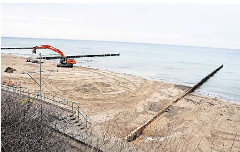
Die Bauarbeiten am Strand von Nienhagen sind beendet. 700 neue Pfähle wurden in die Bühnenreihen gesetzt. FOTO: SABINE HÜGELLAND
