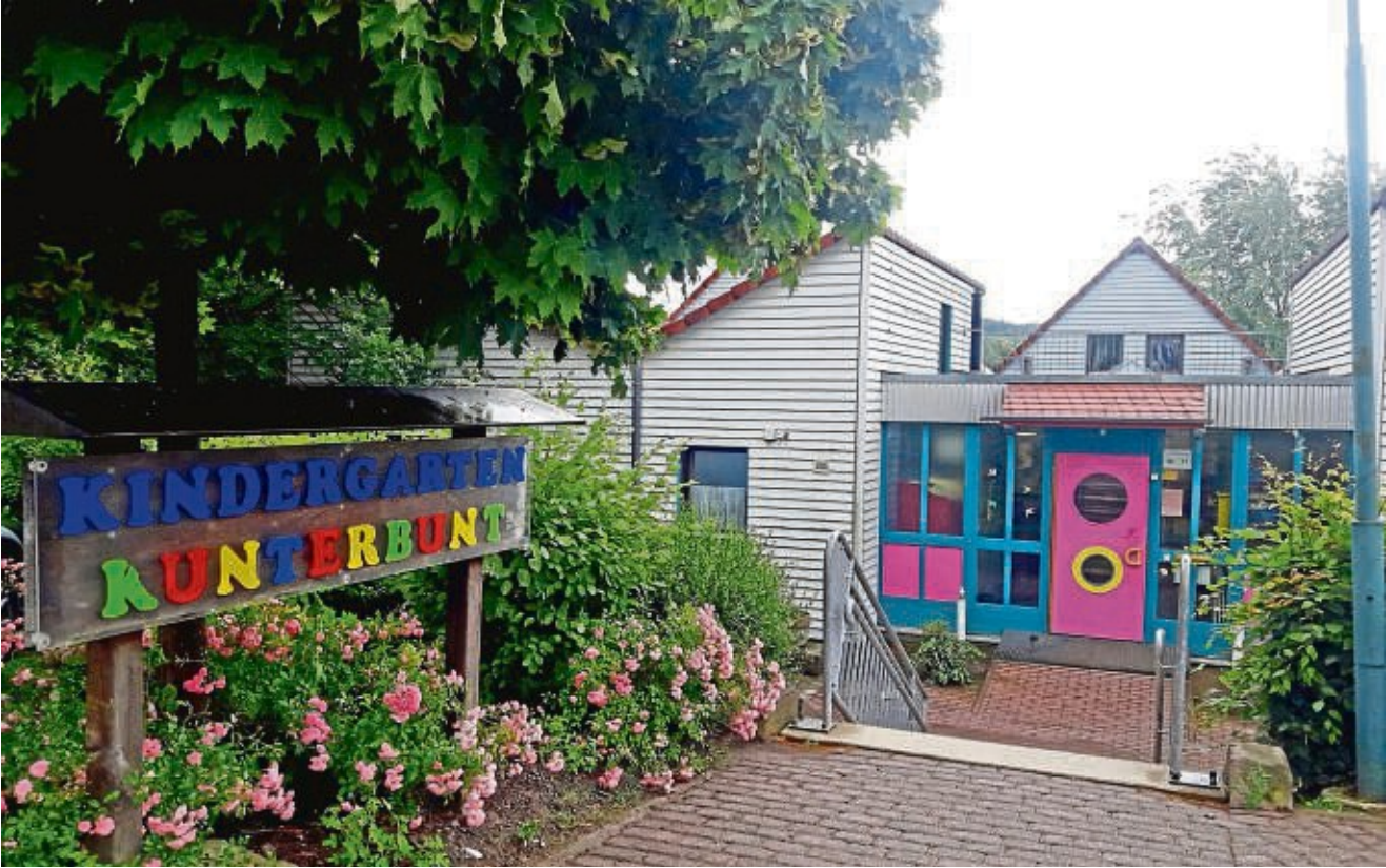
Wie in zahlreichen Kommunen müssen auch in der Gemeinde Helsa neue Kitaplätze geschaffen werden. Ein Anbau in Eschenstruth soll 1,3 Millionen Euro kosten. ARCHIVFOTO: AWO/NH
