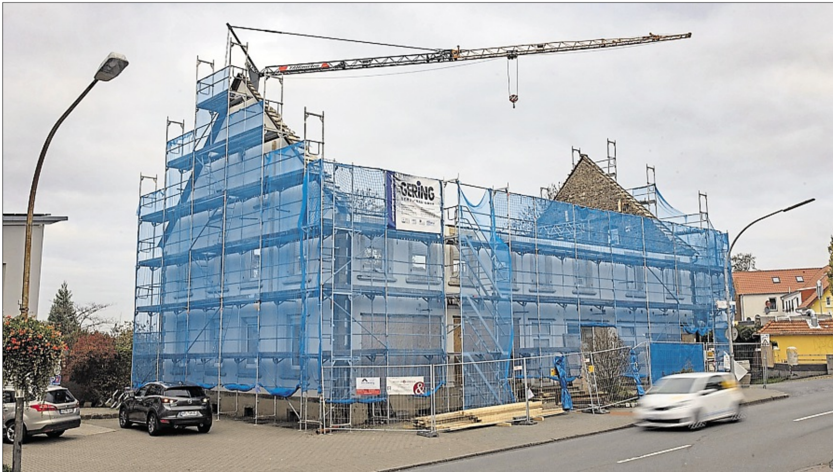
Das Haus an der Bremer Straße in Bohmt wird kernsaniert. 2021 soll hier eine gemeinsame Praxis mit mehreren Hausärzten eröffnen.
