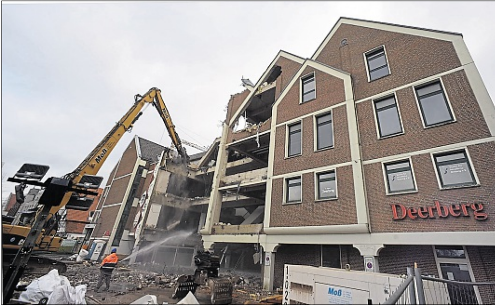
Das ehemalige Kaufhaus Deerberg in Lübbecke muss für das neue Einkaufszentrum Westertor weichen.
