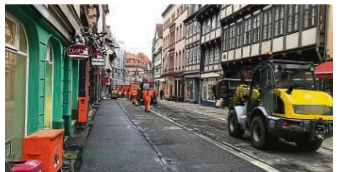
Der westliche Abschnitt der Roten Straße
