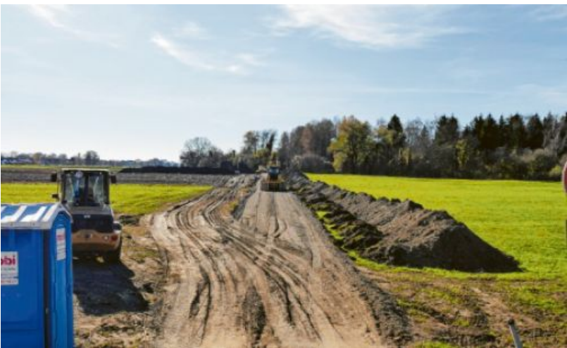
Am Rande der Gebiete Point IV und Point V wird ein neuer Feldweg angelegt. Dadurch muss der landwirtschaftliche Verkehr nicht direkt durchs zukünftige Wohngebiet fahren. Foto: Elmar Knöchel
