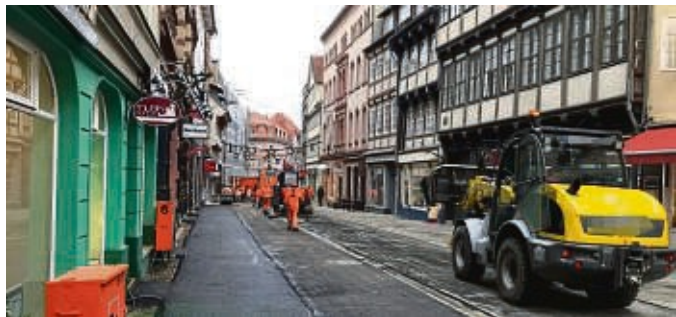
Der westliche Abschnitt der Roten Straße in Göttingen: Der Ausbau wurde jetzt zunächst gestoppt. Im neuen Jahr geht es weiter. FOTO: BERND SCHLEGEL
