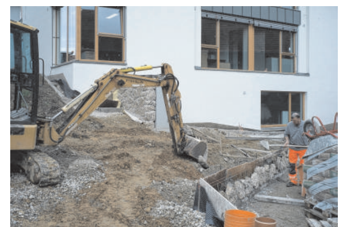
Die Außengestaltung benötigt noch ein paar Tage.
