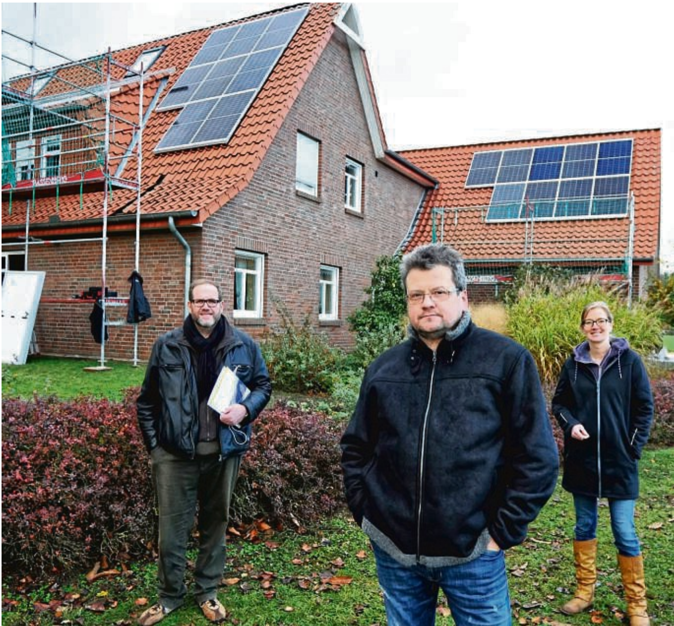
Hauseigentümer Frank Nothnagel (Mitte) aus Morsum hat sich für die Installation einer Fotovoltaik-Anlage entschieden – sehr zur Freude auch von Janine Schmidt-Curreli (Energieagentur) sowie Claas Rohmeyer von der Firma Adler-Solar. FOTO: HA
