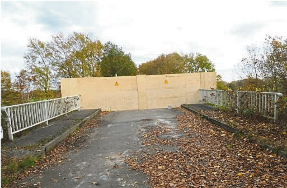
Hier sollen auch keine Fußgänger mehr die Brücke über die Bahnstrecke queren. Mit einer Holzwand ist sie – auch wegen der Bahn-Oberleitung – abgesperrt worden.
