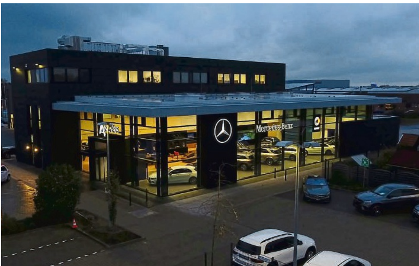
Nach Einbruch der Dunkelheit kommt der aufwendig beleuchtete Showroom des Autohauses Anders in Vechta in besonderer Weise zur Geltung. Fotos: Autohaus Anders
