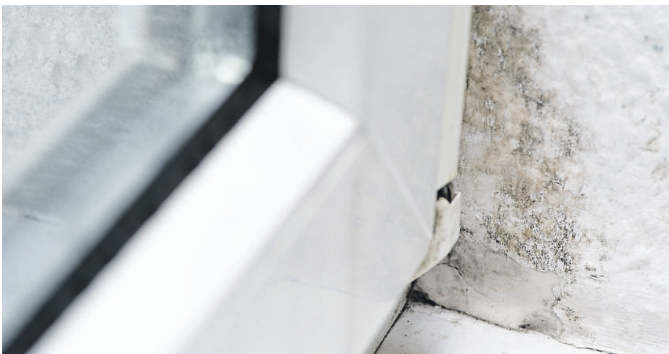
Der schwarze Belag an der Wand ist gefährlicher Schimmel. Vorbeugend hilft regelmäßiges Lüften.
