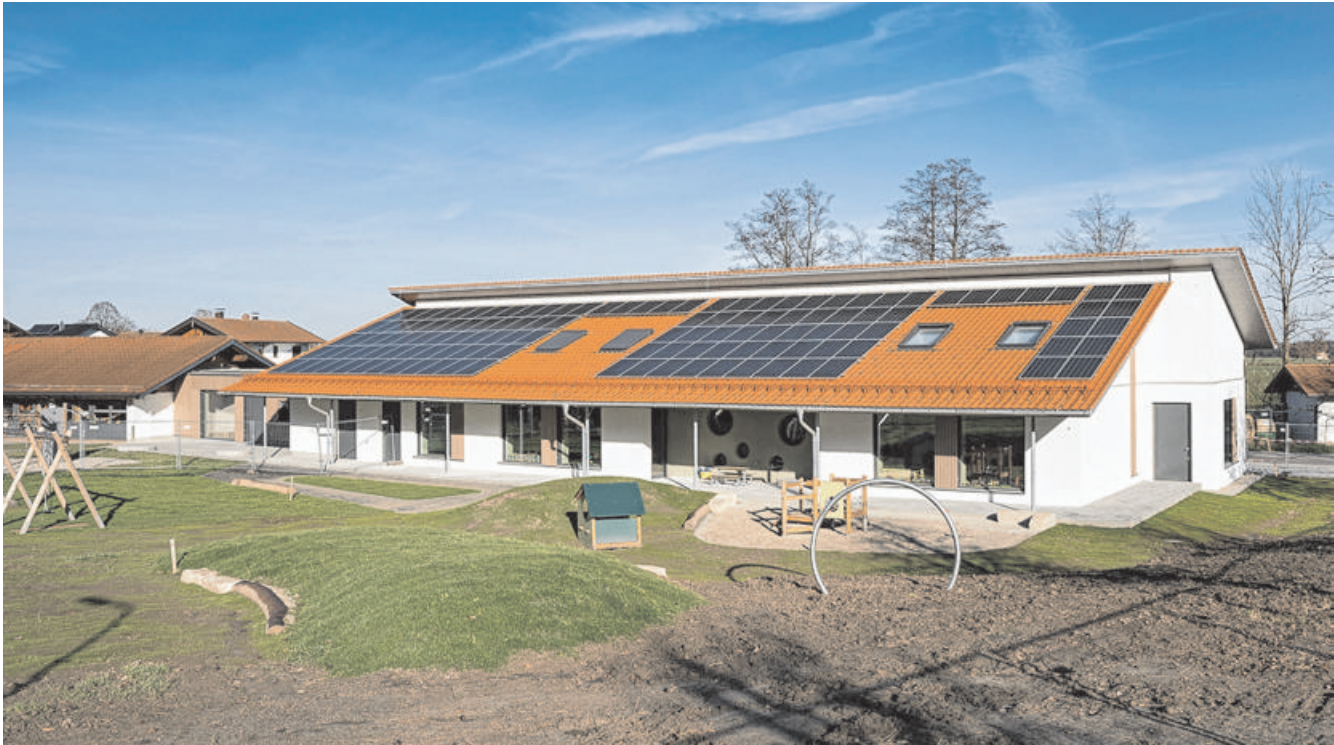
Der kürzlich vergrößerte Kindergarten „Vogelnest“ in Derndorf wurde mit einer Fotovoltaikanlage ausgestattet. Die Grundschule in Au erhält im nächsten Jahr eine gesunde Heizung.
