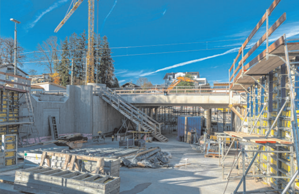
Die Stahlbrücke , die für einen bequemen und sicheren Weg von den Park- & Ride-Parkplätzen an der Haßlerstraße zum Bahnhof sorgen soll, soll jetzt knapp über 171 000 Euro kosten.
