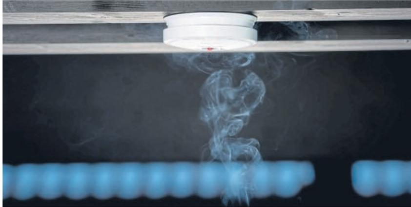
**An der Zimmerdecke ist der richtige Platz:** Der Rauchmelder wird am besten in der Raummitte montiert und befindet sich idealerweise mindestens 50 Zentimeter von den Wänden entfernt.
