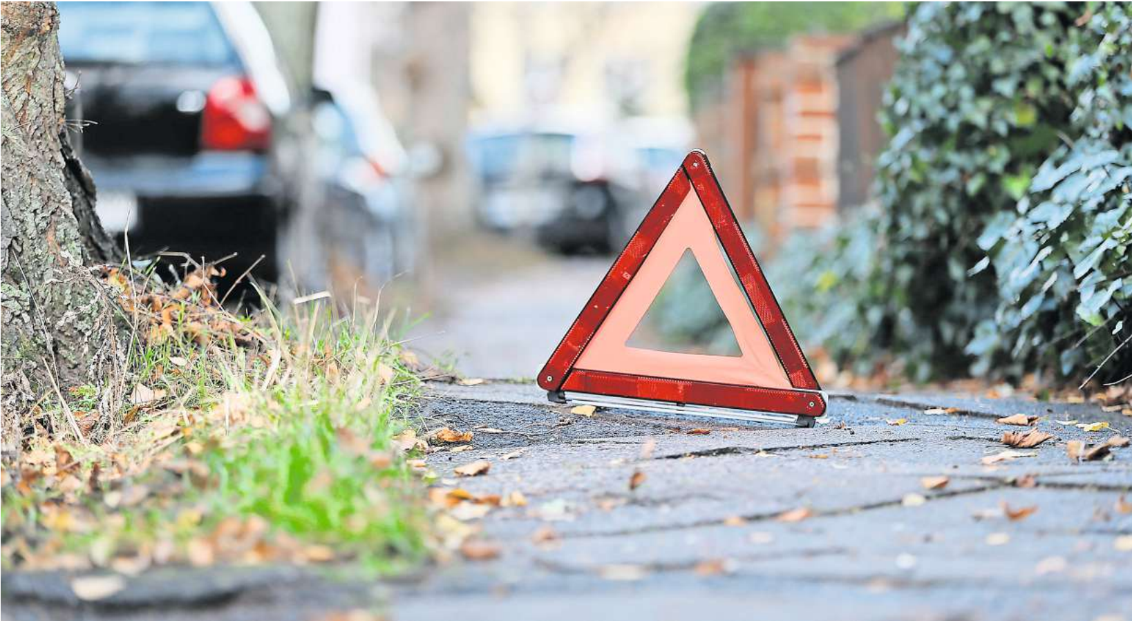
Achtung – gefährlich. Der Gehweg in der Hohelandstraße ist voller Stolperfallen.
