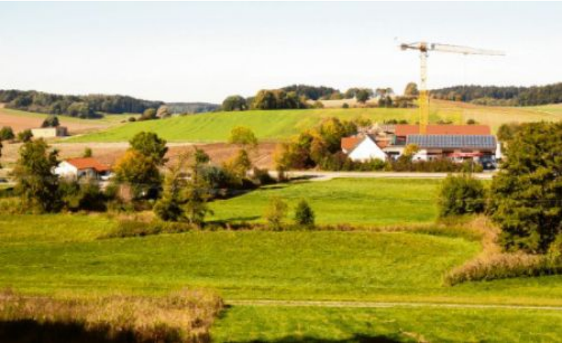
Das Bild zeigt das Betriebsgebäude der Schiltberger Kläranlage: (links) Die Gemeinde braucht nun eine wasserrechtliche Genehmigung. Foto: M. Schmidberger (Archiv)
