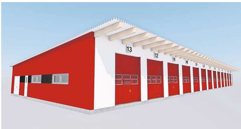
Platz für Fahrzeuge des Katastrophenschutzes des DRK, der DLRG und der Johanniter-Unfallhilfe bietet die neue Halle in der Rugardstraße in Bergen.
