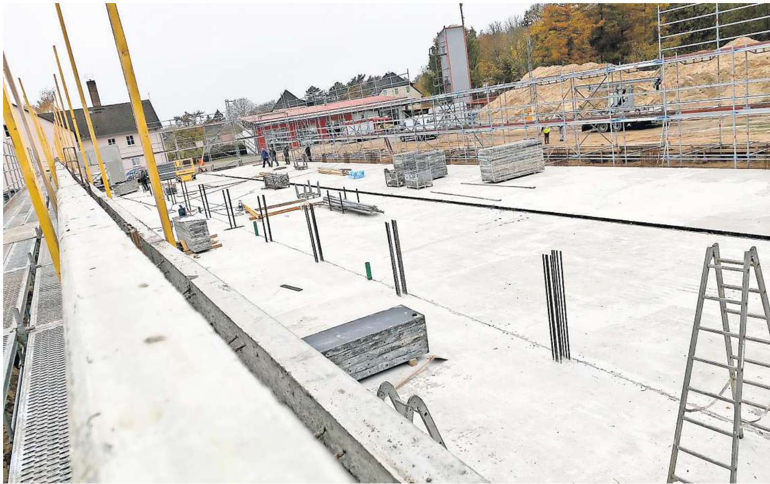
Noch ist nicht viel zu erkennen: Aber im Sommer des kommenden Jahres soll die Fahrzeug- und Lagerhalle für den Katastrophenschutz fertig sein.
