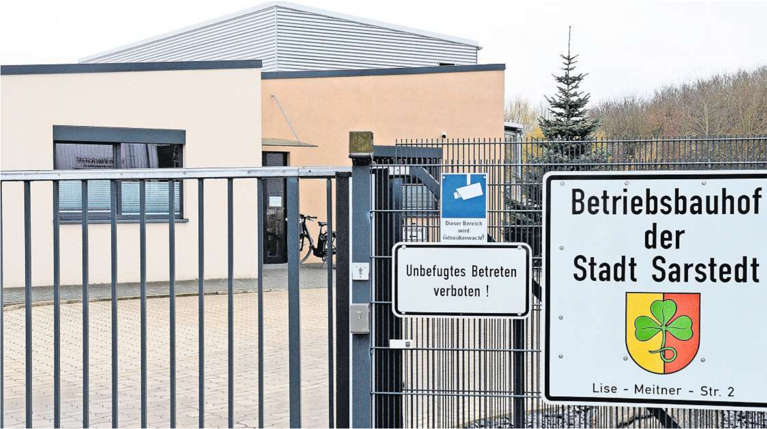
Möglicherweise wird der Bauhof demnächst bis zur Hälfte mit Strom einer Fotovoltaikanlage versorgt.
