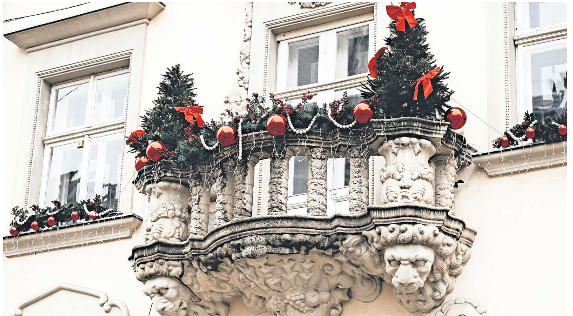
Sicher befestigen: Von Weihnachtsschmuck am Balkon darf keine Verletzungsgefahr ausgehen. Entstehen durch Dekorationen Schäden an der Fassade, müssen Mieter dafür im Zweifel selbst aufkommen.
