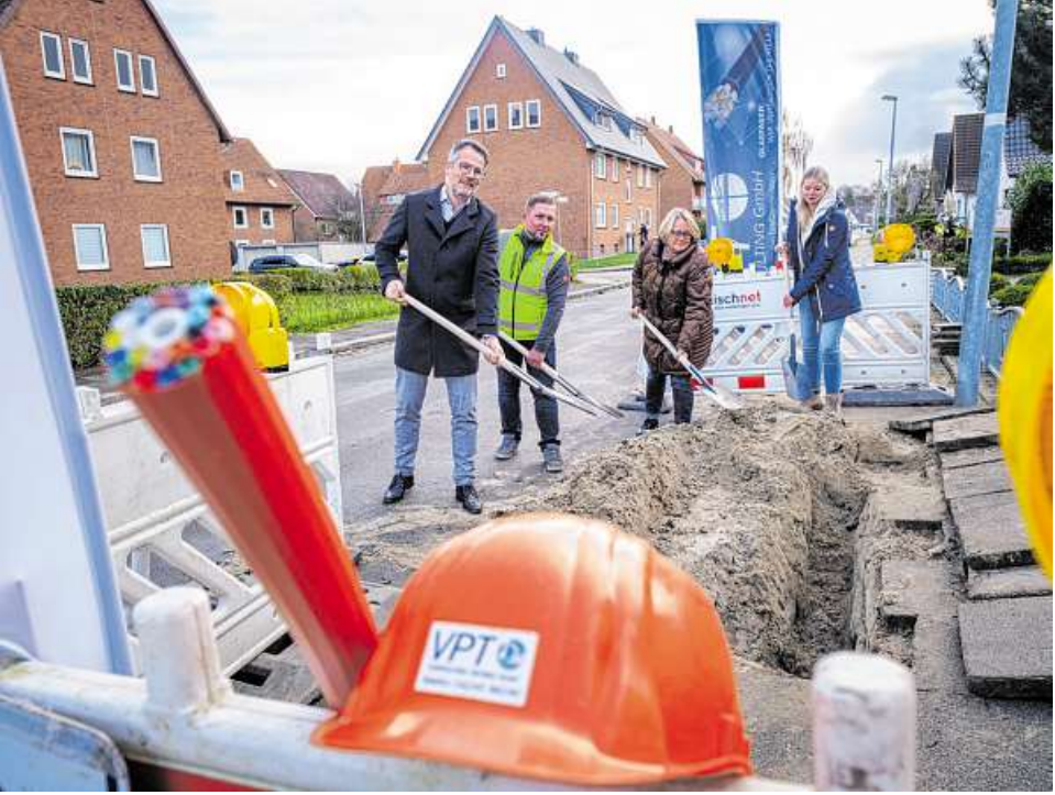
Spatenstich für Glasfaserausbau (von links): Andreas Niehaus, Anatoli Krieger, Suse Laue und Marina Lange. FOTO: VASIL DINEV
