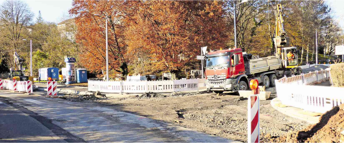
Bis Ende dieser Woche sollen die neue Bushaltestelle fertig gebaut und die Belagsarbeiten an der Kreuzung Rohracker-/Dürrbachstraße abgeschlossen sein. Dann wird auch die Sperrung in Richtung Speidelweg wieder aufgehoben. Fotos: Alexander Müller
