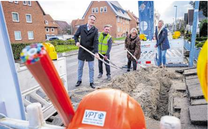
Spatenstich für Glas-faserausbau (von links): Andreas Nie-haus, Anatoli Krieger, Suse Laue und Ma-rina Lange.
