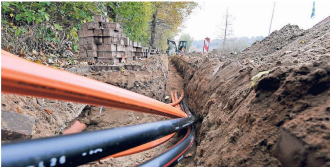
Auf dieser Baustelle werden Kabel für den Anschluss von Breitband-Internetverbindungen verlegt.
