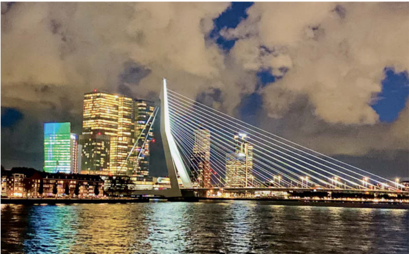
Direkt vor der Erasmusbrücke liegt die „Viva Tiara“ in Rotterdam.
