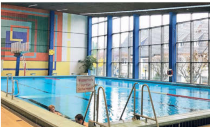
Das Mettmanner Hallenbad ist in die Jahre gekommen. Eine Sanierung wird allerdings teuer. Foto: von
