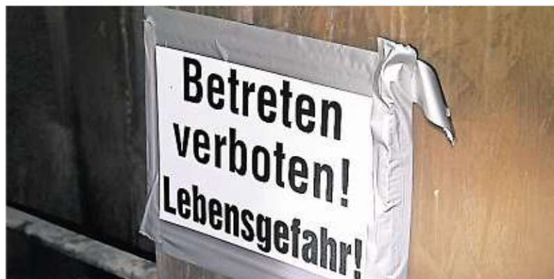
Direkt am Eingang warnt ein Schild vor dem Betreten der Anlage. Es besteht Lebensgefahr.
