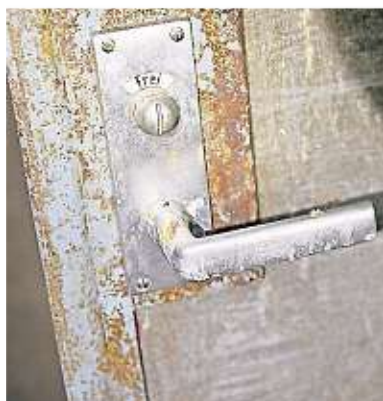
Die Türen zu den Toiletten sind noch intakt.
