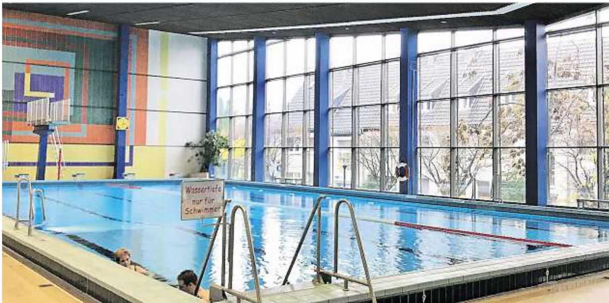
Das Mettmanner Hallenbad ist in die Jahre gekommen. Eine Sanierung wird allerdings teuer.
