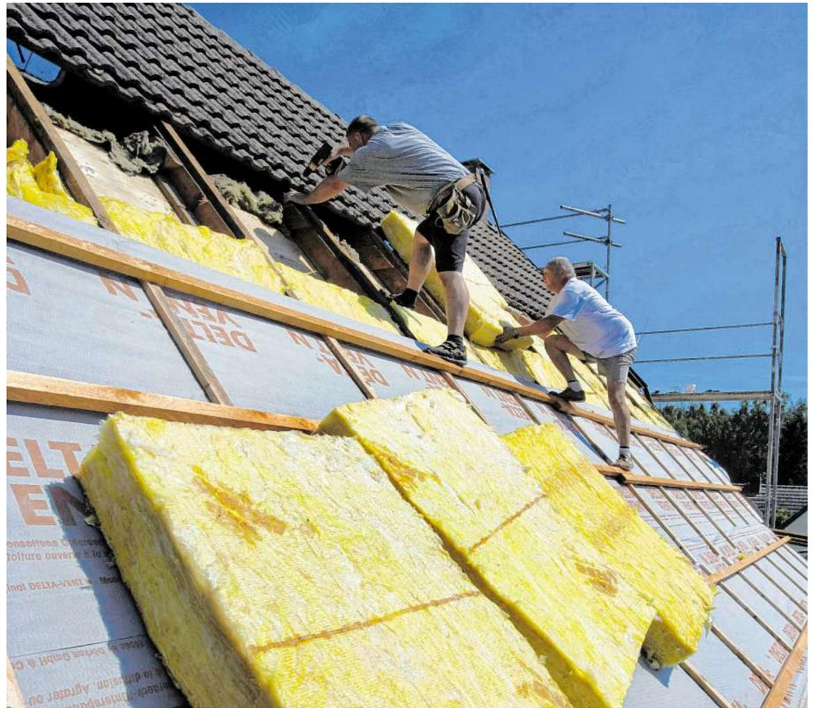
Über das Dach eines Hauses könnten erhebliche Mengen Wärmeenergie entweichen. Bei dessen Dämmung muss laut Energieberater sowohl auf Winddichtigkeit wie Luftdichtigkeit geachtet werden.
